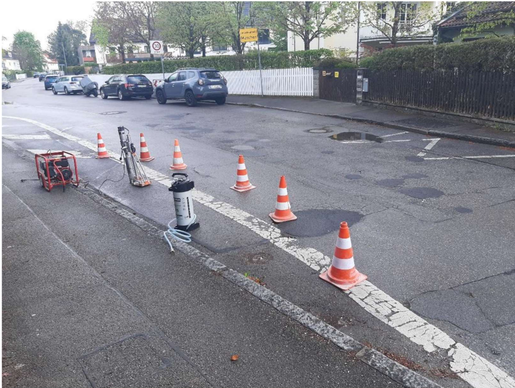
Wittelsbacherstraße Westseite Blickrichtung Norden -> Rotkäppchenplatz
