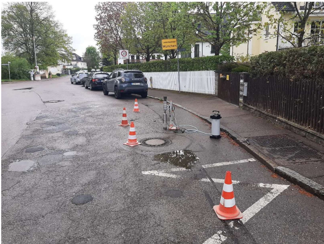
Wittelsbacherstraße Ostseite Blickrichtung Norden -> Rotkäppchenplatz
